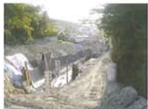
(1) 挖掘、挡水、保护防水布的铺设工程
